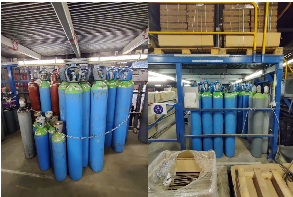
Figure 67. Mesures de protection des bonbonnes de l'entrepôt
