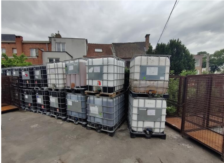
Figure 72. Conteneurs IBC remplis destinés au remplissage des bouteilles d'extincteur
