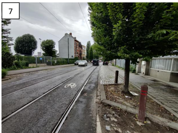
Figure 12. Vue sur la chaussée de Neerstalle devant l'entrée du site, orientation nord
