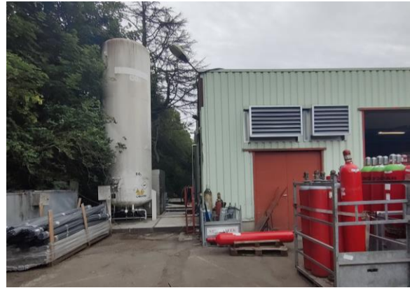
Figure 63. Cuve de CO 2 faisant barrière pour l'accès à l'arrière du site
