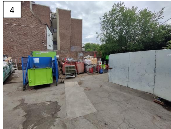
Figure 9. Vue générale sur la déchetterie du site
