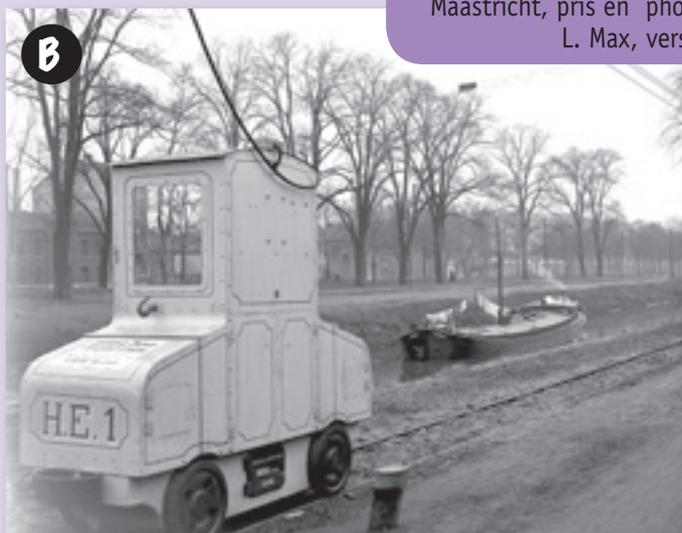
Liège, tracteur électrique pour bateaux sur le canal Liège-Maastricht, pris en photo par L. Max, vers 1926
